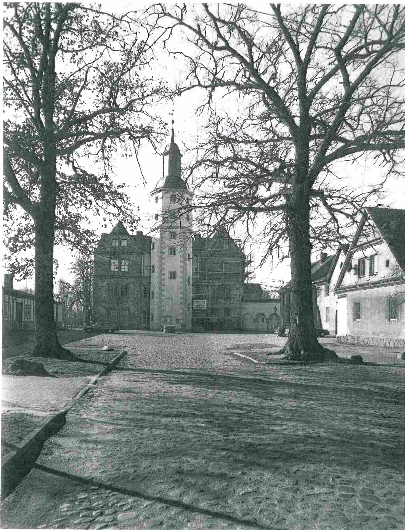
4 Demerthin, Schloss von Norden nach der Restaurierung des Turms; Aufnahme 4.3.1997.
