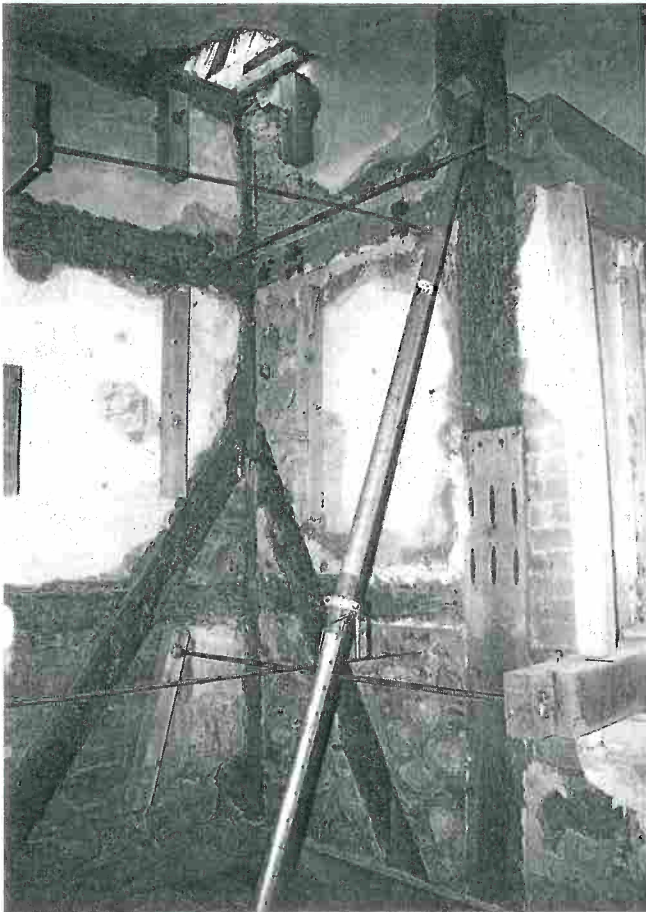
63 Demerthin, Schloss, Nordwestecke, zweites Obergeschoss nach der Fachwerksanierung; die Ecke ist mit Gewindestäben verspannt, das Mauerwerk zusätzlich mit Stahlaußenwinkel, Querschnittsverbolzung und inneren Druckverteilungshölzern gesichert; zerstörte Ständer und Riegel wurden im Beta-Verfahren gewechselt; Aufnahme Juli 1997.
