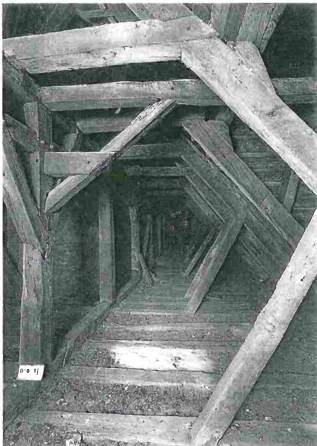
16 Demerthin, Schloss, Kreuzständer im Dachgefüge des Längsdaches (im Bild links), Blick nach Westen; Rähm, Schwelle, Riegel und Kopfband der Längsstuhlwand sind vollständig zu erkennen, der Riegel in der Querstuhlwand ist abgeschnitten; Aufnahme November 1993.
