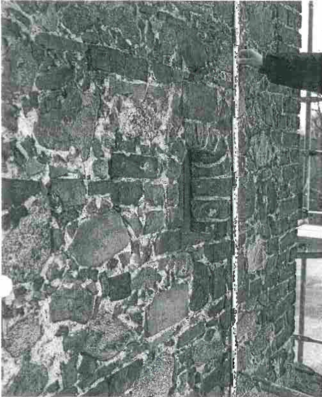
39 Demerthin, Schloss, Südfassade, typisches Mischmauerwerk der Renaissance-Bauteile der Zeit um 1600 vom ehemaligen Treppenturm; Aufnahme 13.3.1998.
