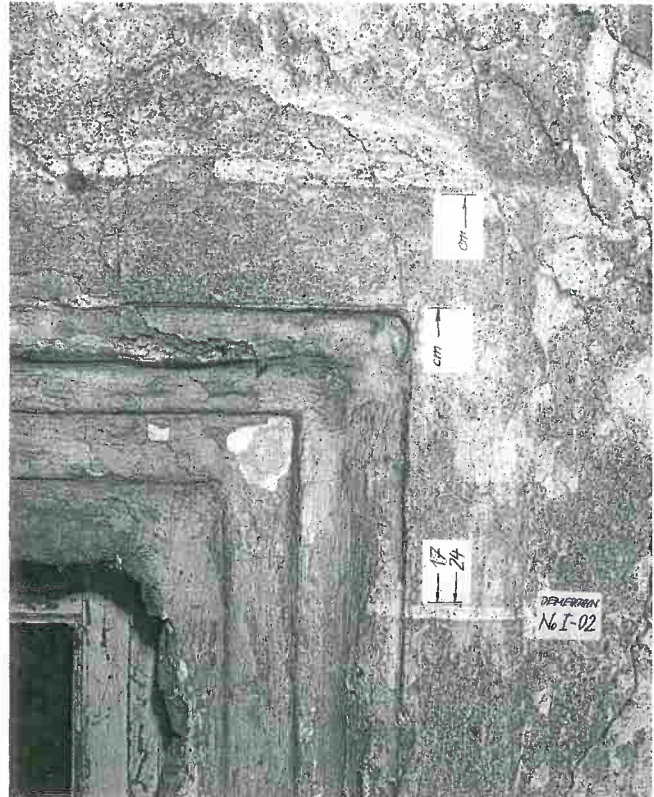
41 Demerthin, Schloss, Nordfassade, Abschnitt eines barock geputzten Fenstergewändes, in der Struktur und farblich von der Putzfläche abgesetzt, mit aufgemalter Fuge im Sinn einer Werksteinimitation; Aufnahme 15.10.1997.
