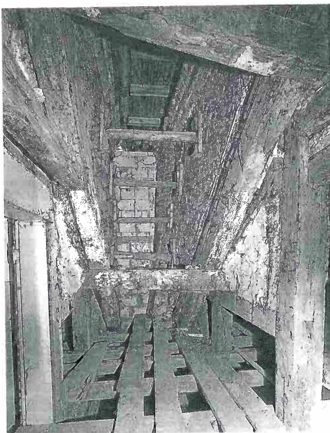
15 Demerthin, Schloss, Raum 2.19 (vgl. Abb. 13) zwischen dem nord-westlichen und dem mittleren Zwerchhaus mit den geschosshohen Aufschieblingen, den Zwerchhausgesimsen und dem Ziegelmauerwerk des Runderkers hinten rechts; Aufnahme 18.2.1997.
