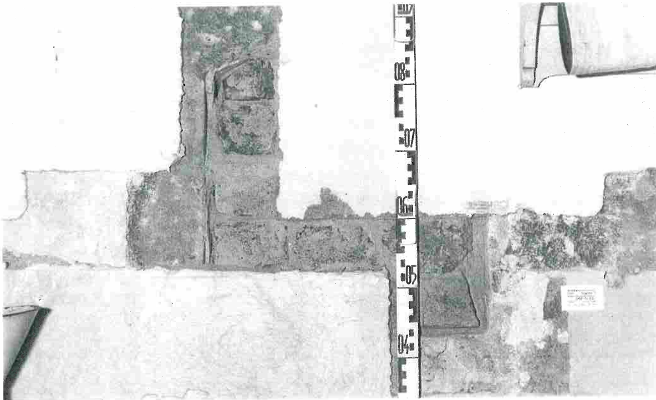
42 Demerthin, Schloss, südliche Wand des größeren gewölbten Raums (Raum 0.10; vgl. Abb. 12), von Raum 0.08 aus gesehen, mit zugesetzter Nischen- oder Fensteröffnung; bei dieser Wand handelt es sich um die ehemalige Außenwand des Vorgängerbaus; Aufnahme Oktober 1998.
